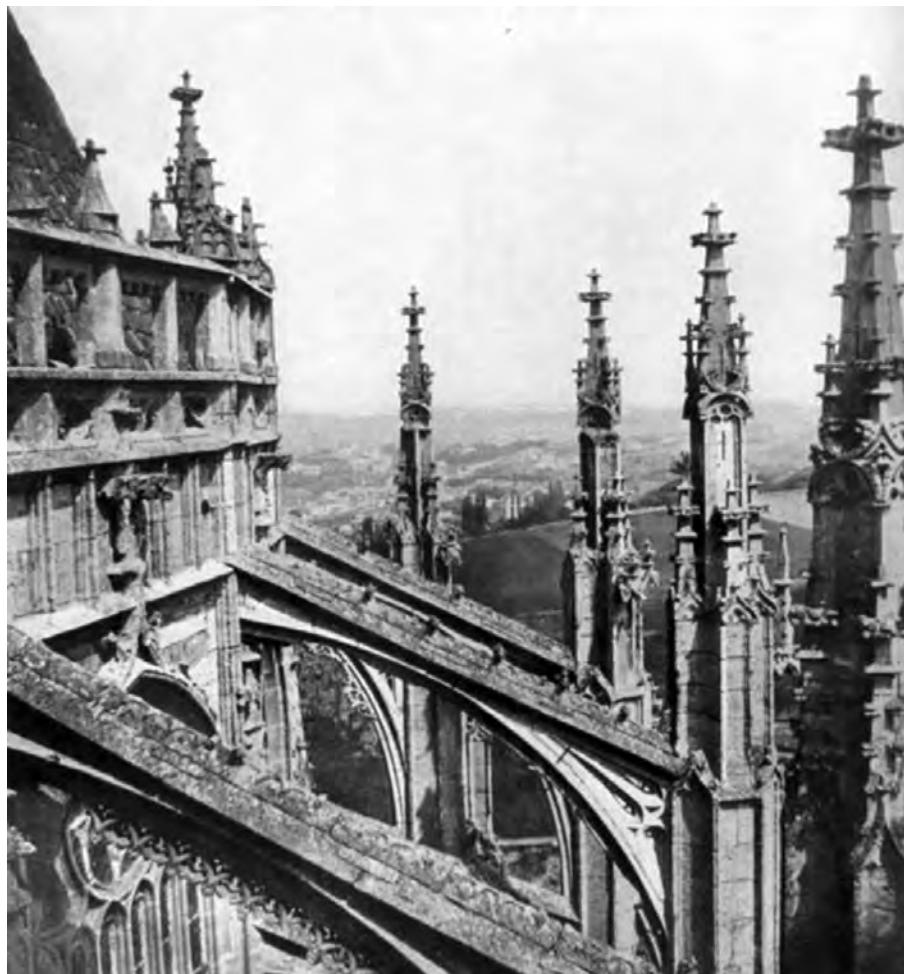
Pohled na vnější opěrný systém kostela sv. Barbory v Kutné Hoře před obnovou. Reprodukce z knihy Karla Vorlíčka Dějiny restaurace a dostavby velechrámu sv. Barbory v Kutné Hoře v letech 1884–1905 (1905).
