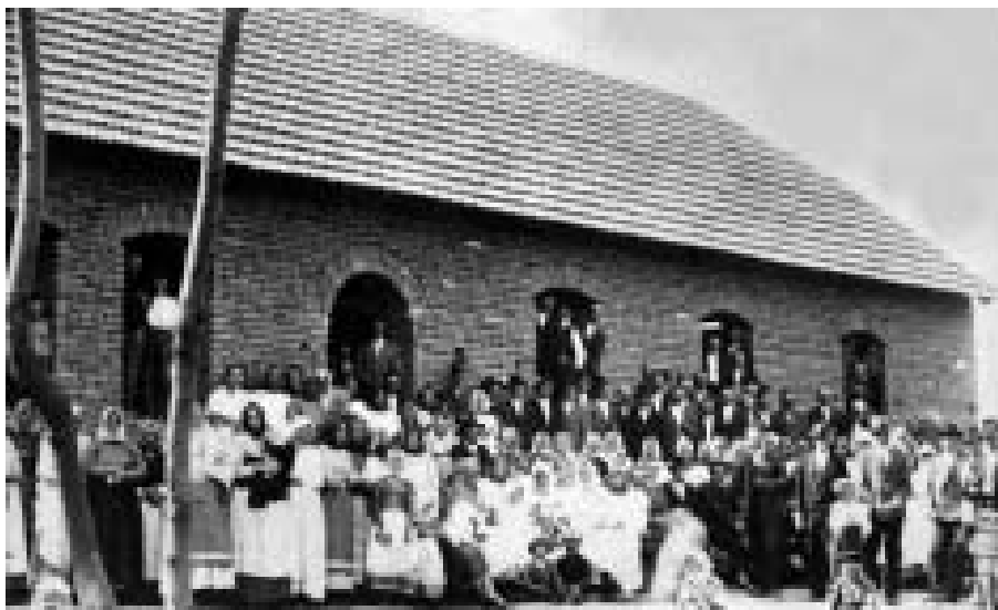
Stavba „horního“ kostela. Archiv autora.
