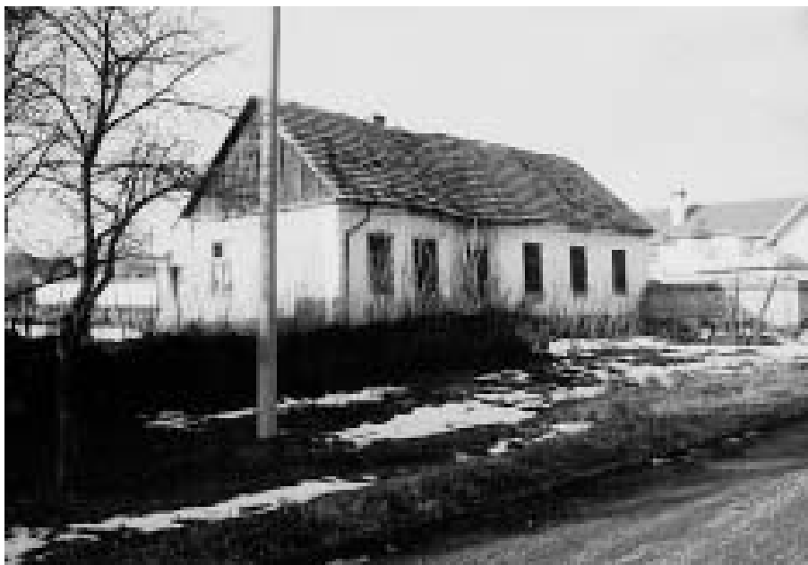
Metodistický (tzv. dolní) kostel, stav v roce 1997. Foto M. Jakoubek.
