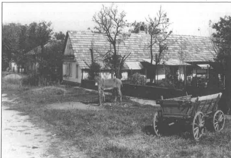
Vojvodovo. Obytný dům z r. 1900 rekonstruovaný v 60. letech. Foto Z. R. Nešpor, 1999
