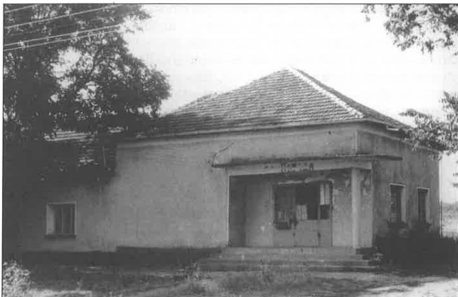
Vojvodovo. Bývalý horní (darbistický) kostel přestavěný na kino. Foto Z. R. Nešpor 1999
