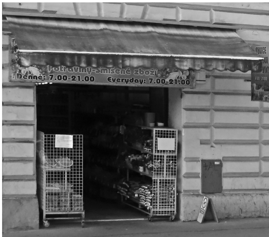
Současný stav bývalého košířského sboru – po opuštění prostor ČČSH byly pronajaty jako vietnamská tržnice. Foto Z. R. Nešpor, 2021.
