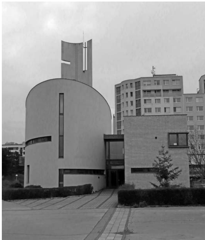
Butovice, respektive nedaleké sídliště Nové Butovice, získaly v novém tisíciletí také nový kostel sv. Prokopa, přiléhající ke stejné zasvěcenému komunitnímu centru. Autorský kolektiv jedné z mála chrámových novostaveb současnosti vedl Zdeněk Jiran, stavba byla realizována v letech 2000–01. Foto Z. R. Nešpor, 2023.
