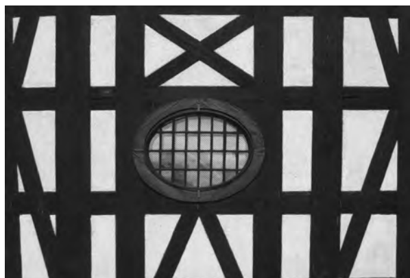
Detail hrázděné konstrukce použité u kostela v Milíči. Foto Z. R. Nešpor, 2013.
