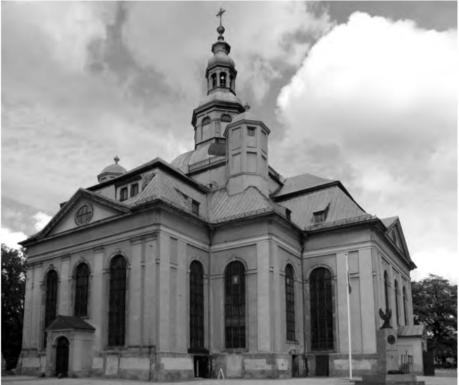
Kostel Sv. Kříže v Jelení Hoře, dnes římskokatolický vojenský posádkový kostel Povýšení sv. Kříže. Foto Z. R. Nešpor, 2013.
