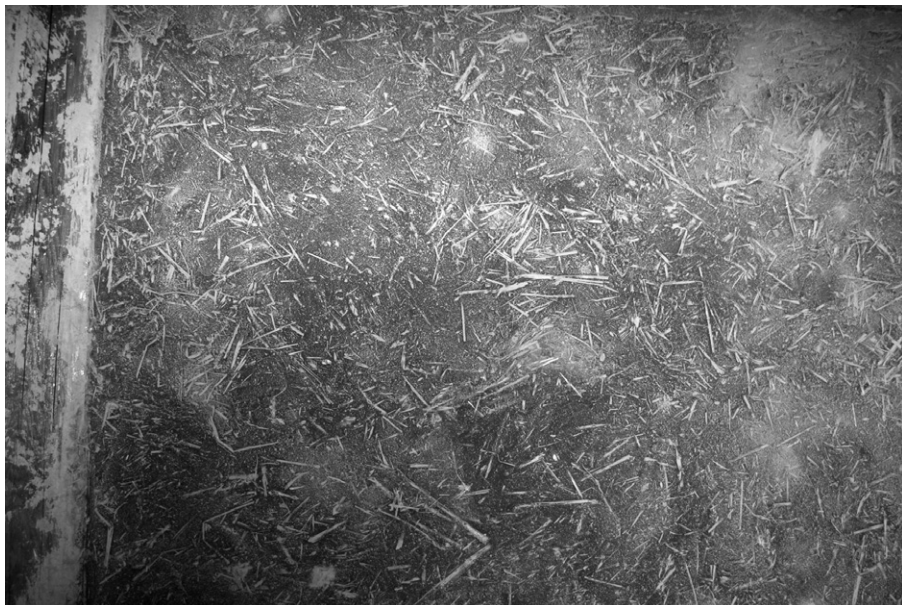
Výplň hrázděné konstrukce mírového kostela ve Svidnici. Foto Blanka Altová, 2012.
