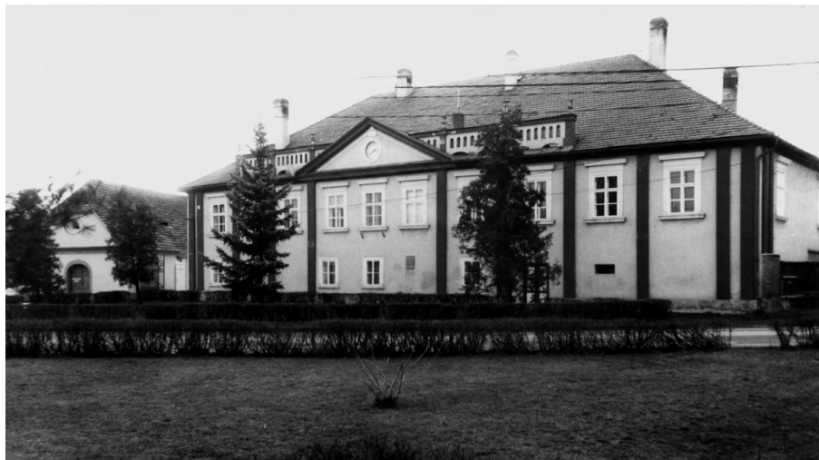
Obr. č. 2: Zámek z 18. století, bývalý statek, reemigrantem získaný v restituci; částečně adaptováno v 90. letech. Obec se 400 obyvateli, střední Čechy. Foto autor, 2002.
